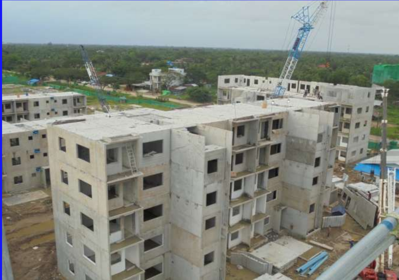
6 th FL Slab လုပ်ငန်းဆောင်ရွက်ပြီးစီးပုံ။
