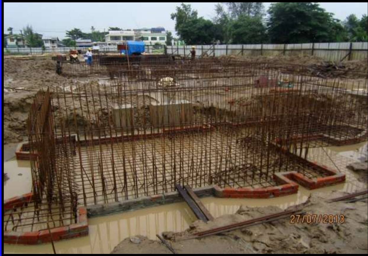
Bldg-C2 GroundTank-1 အတွက် သံဆင်ခြင်းလုပ်ငန်းဆောင်ရွက်နေပုံ
