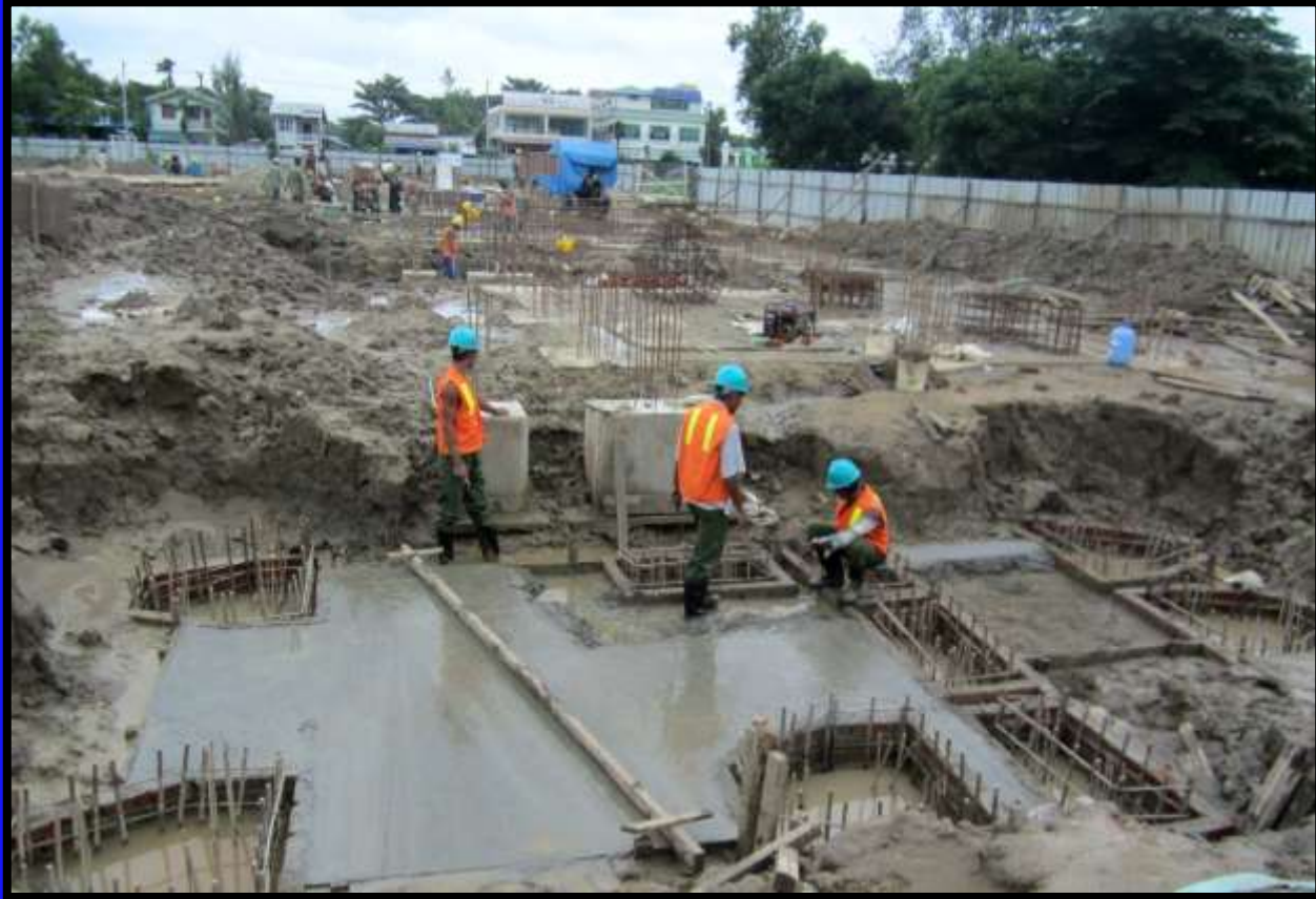
Bldg-C2 GroundTank အတွက် Lean concret လောင်းနေပုံ
