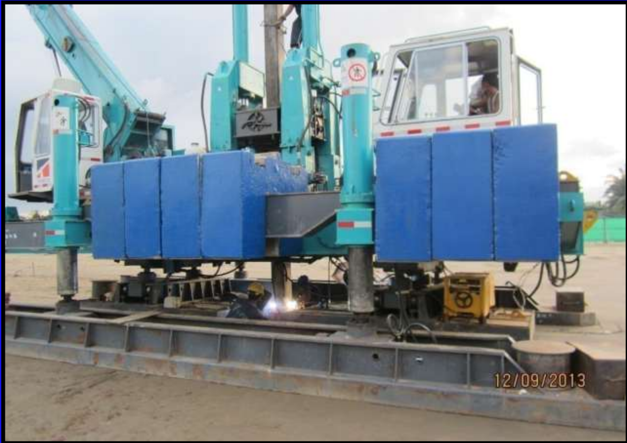
Bldg-B5 Pile ဆက်ခြင်းလုပ်ငန်းဆောင်ရွက်နေပုံ
