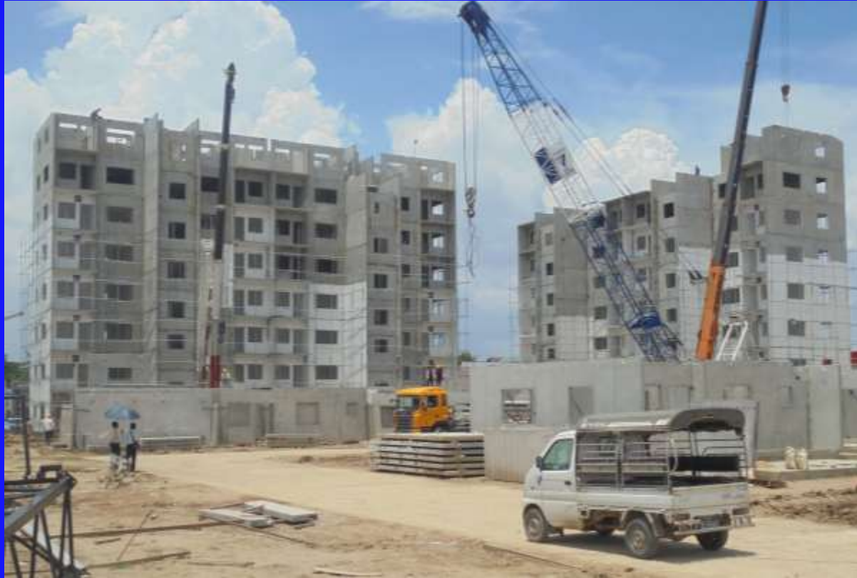
8 th FL Wall Installation လုပ်ငန်းဆောင်ရွက်နေပုံ။
