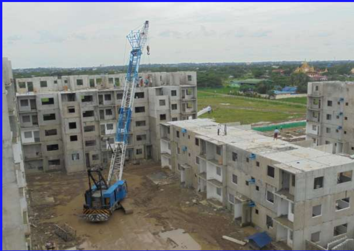
Building C-2 6 th FL Wall Insallation လုပ်ငန်းဆောင်ရွက်နေပုံ ။
