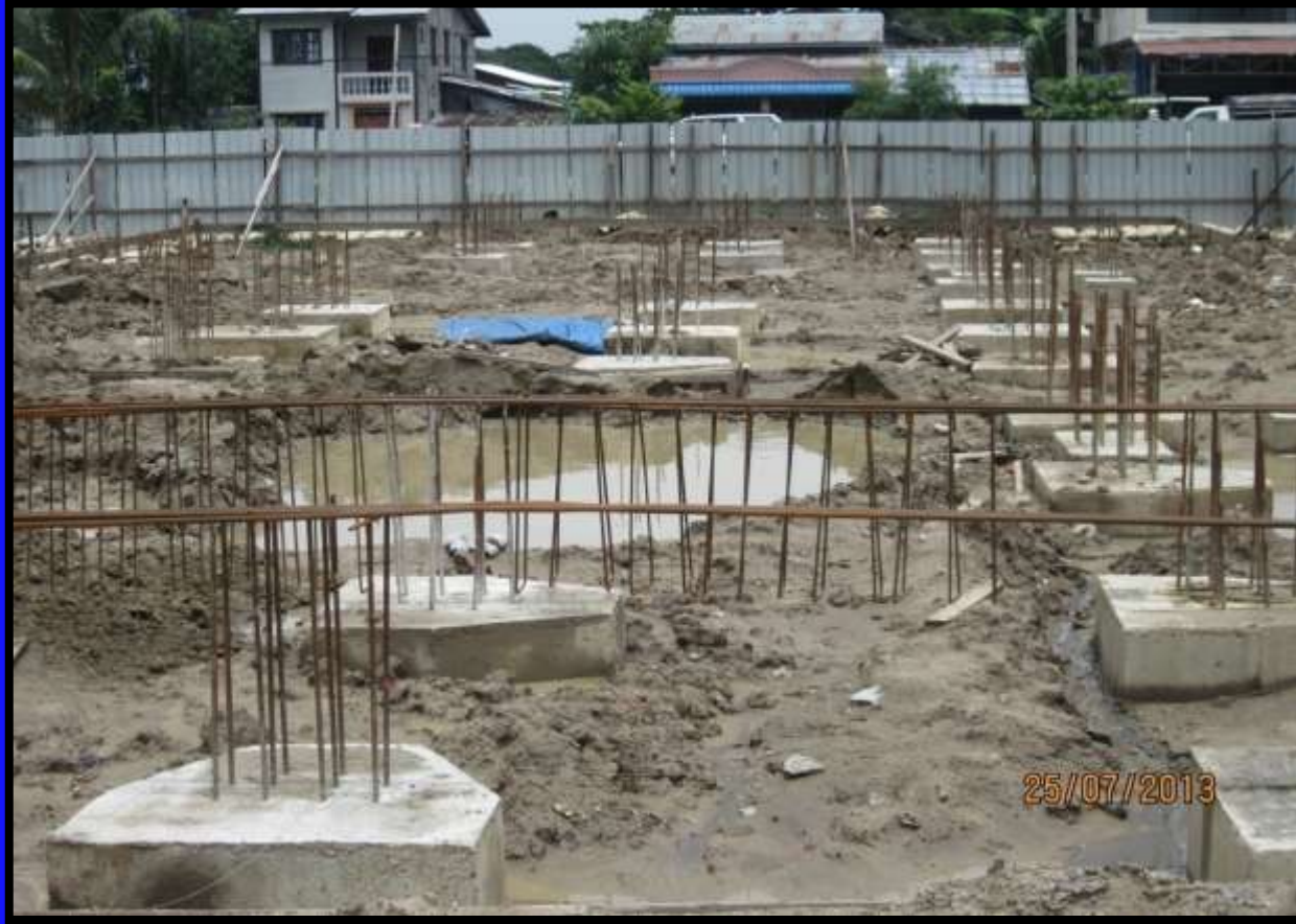
Bldg-C1 Pile Cap လောင်းခြင်း လုပ်ငန်းဆောင်ရွက်ထားပုံ
