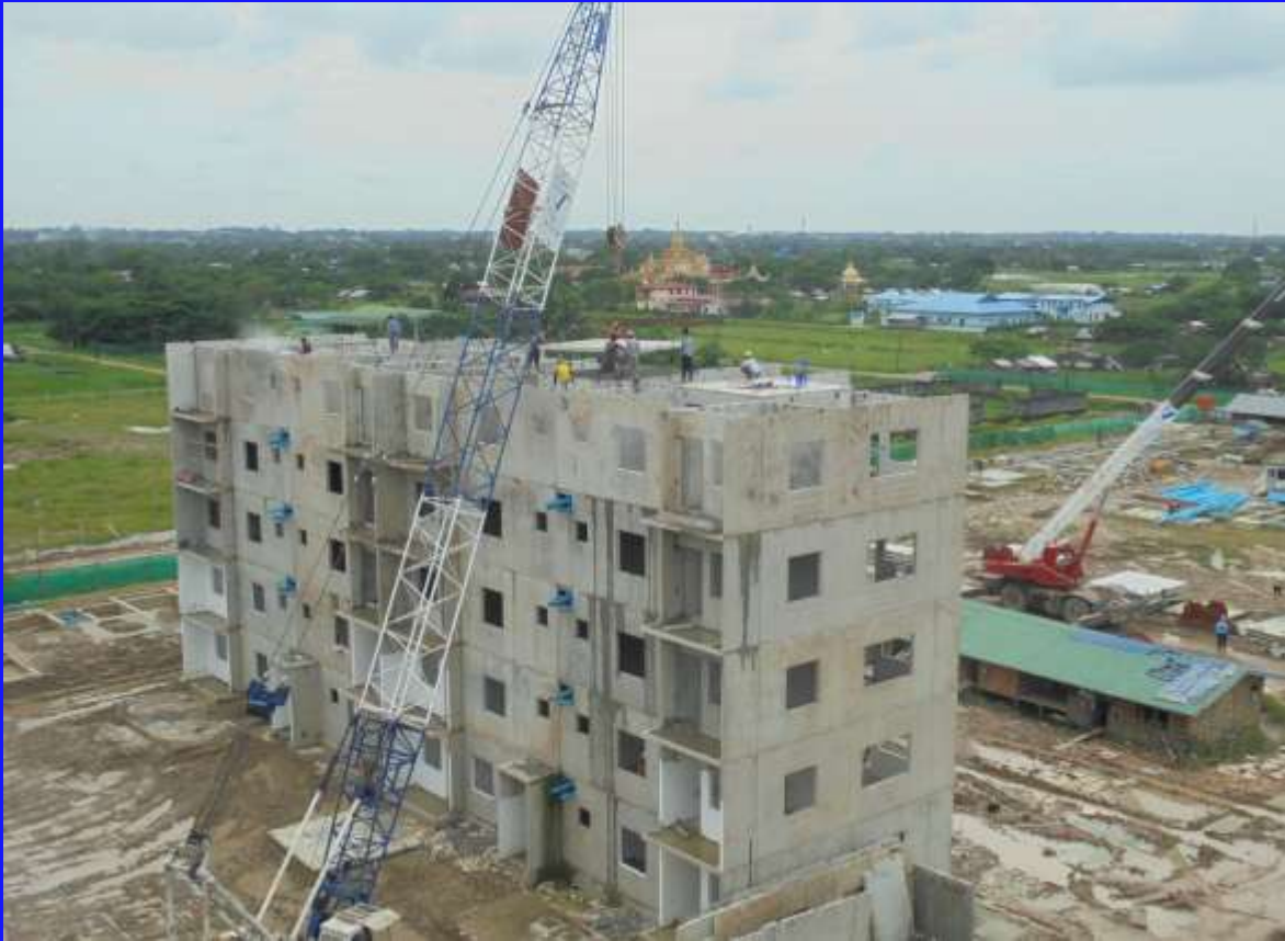
Building B-4 6 th FL Slab Installation လုပ်ငန်းဆောင်ရွက်နေပုံ ။
