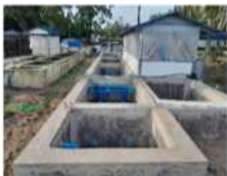
Final Effluent Tank
