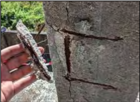
Spalling
